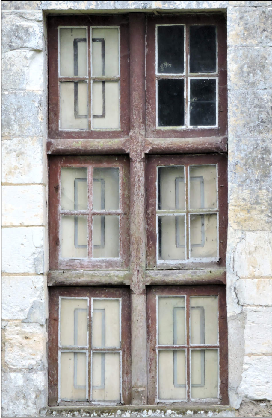
Fig. 4.1. Elévation extérieure (N5)
