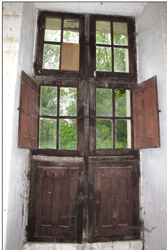
Fig. 4.5. Elévation intérieure (S1)
