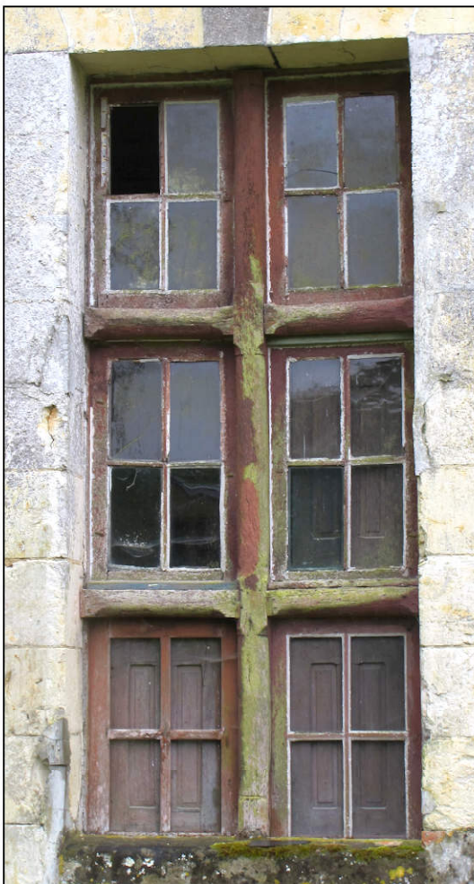
Fig. 4.4. Elévation extérieure (N3)
