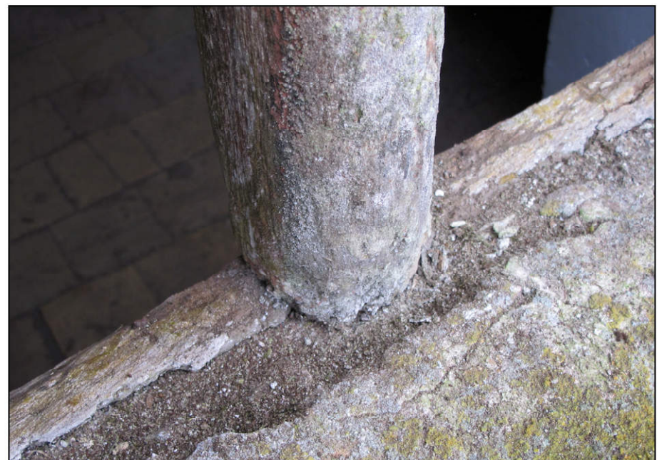
Fig. 3.6. Meneau / pièce d'appui
