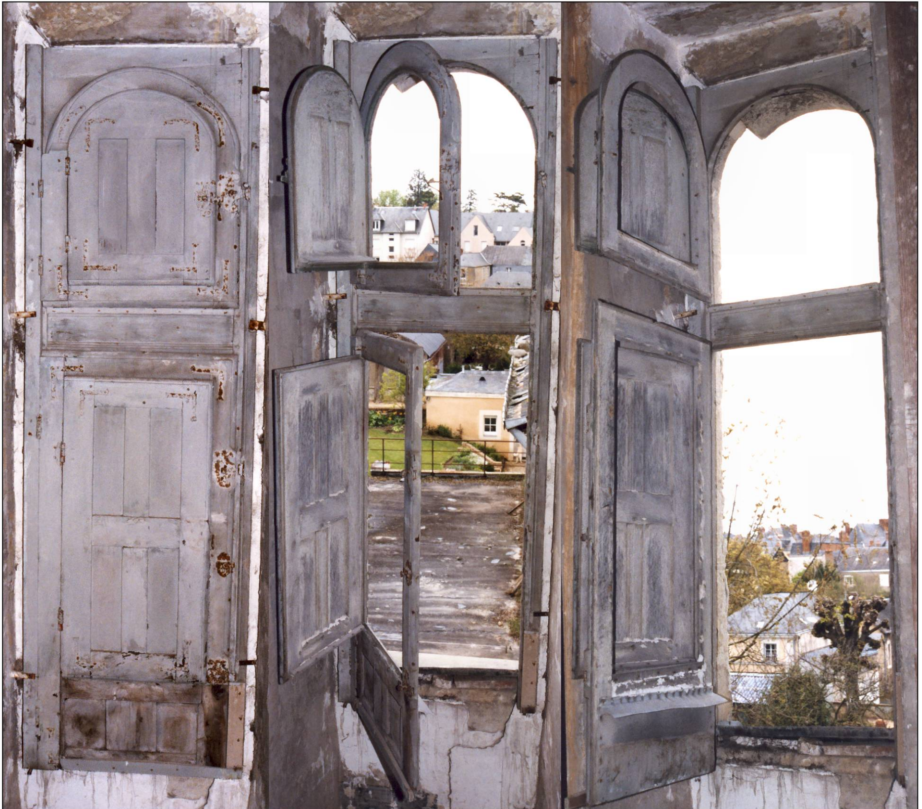
Fig. 1.1. Demi-croisée (élévation intérieure)
