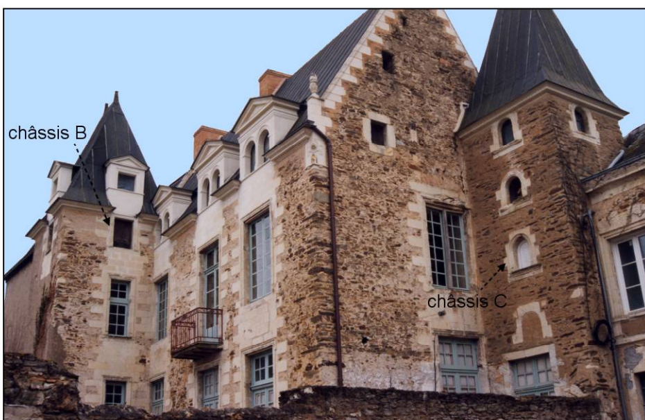
Fig. 1.2. Façade est et pignon nord
