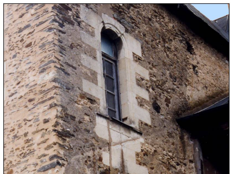
Fig. 1.3. Fenêtre (escalier / aile ouest)
