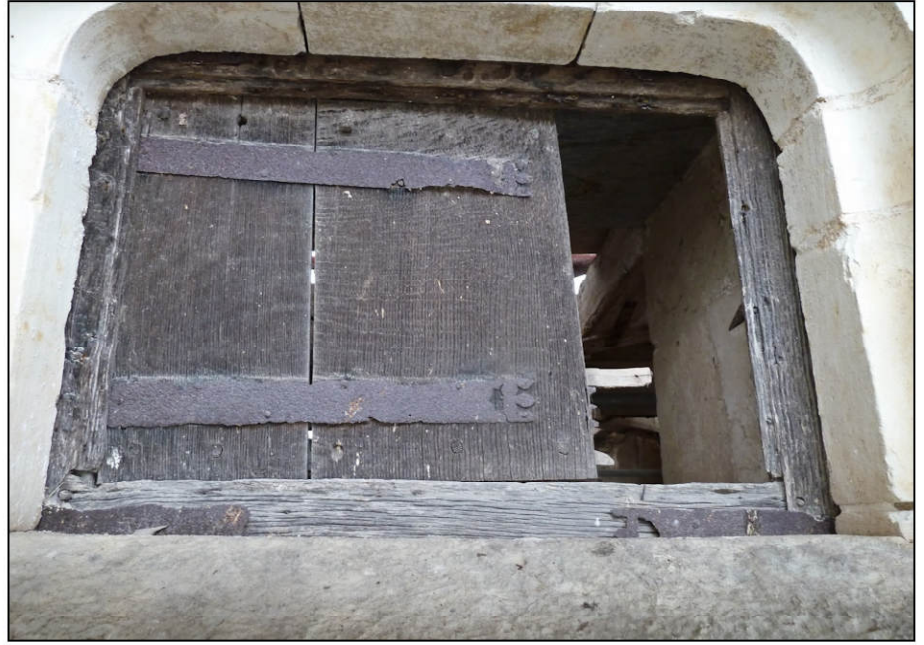
Fig. 4.2. Elévation extérieure (avant restauration)*
