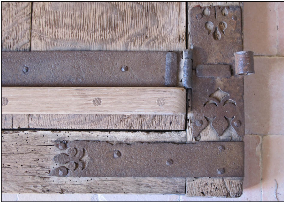
Fig. 4.3. Penture à charnière et étrier
