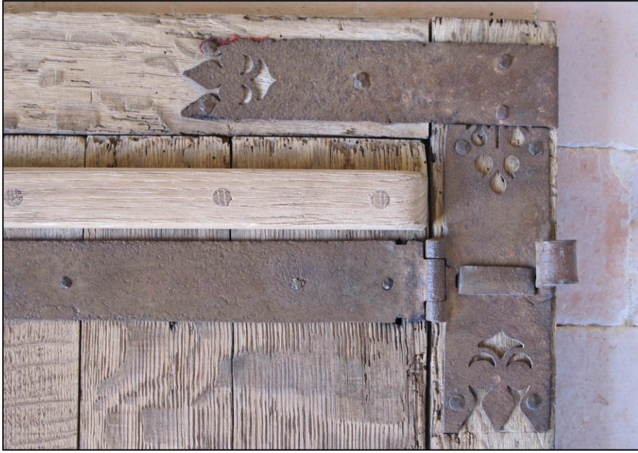
Fig. 4.1. Penture à charnière et étrier
