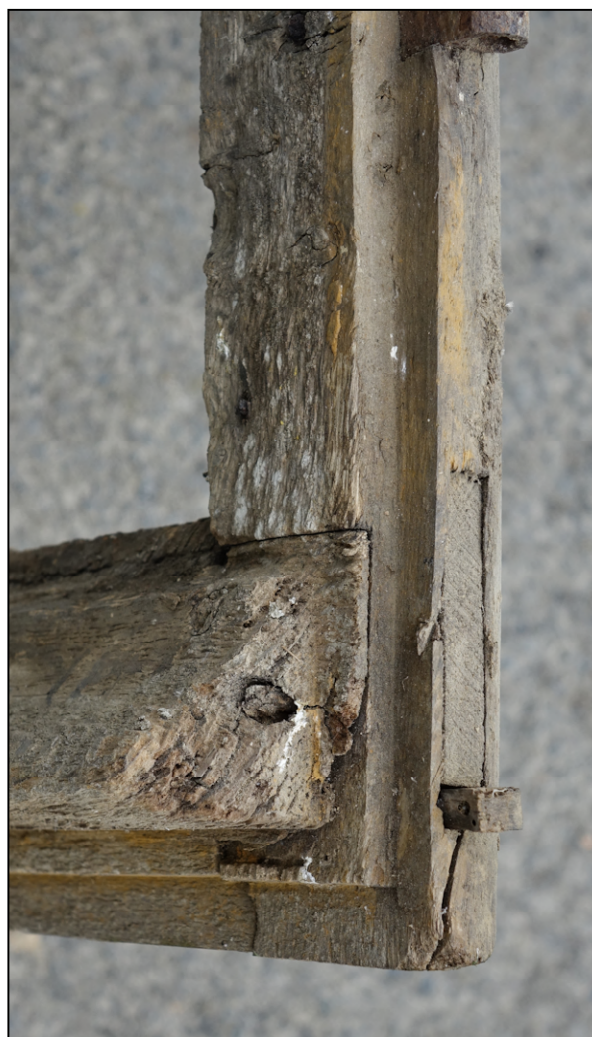
Fig. 4.5. Assemblage du jet d'eau
