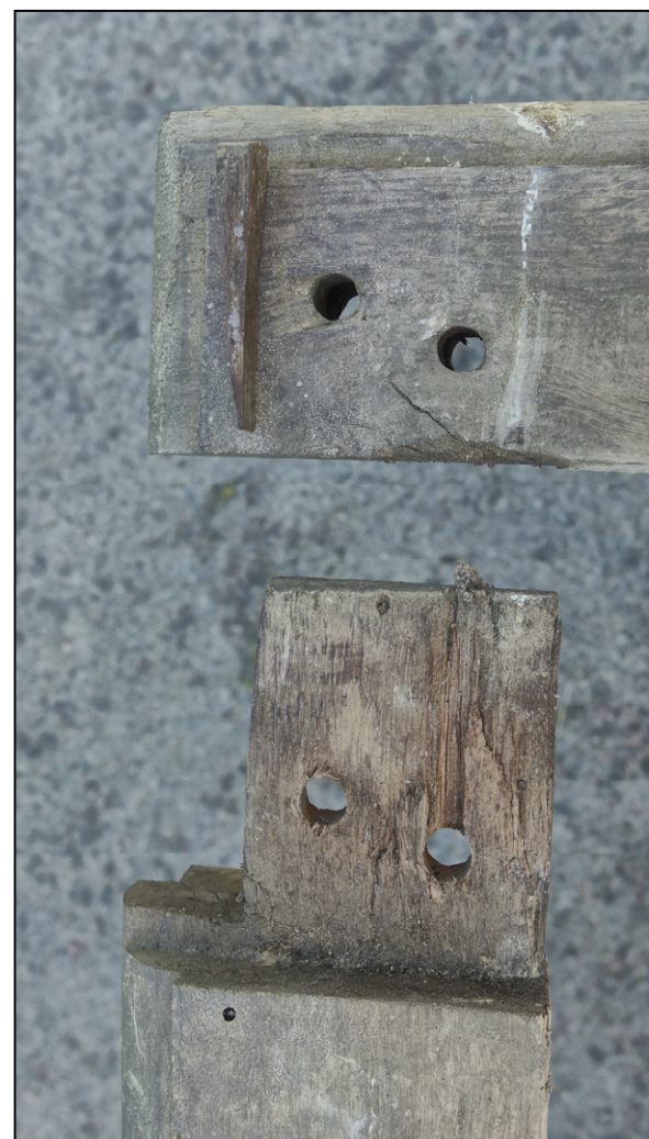
Fig. 4.6. Assemblage d'un battant de rive*
