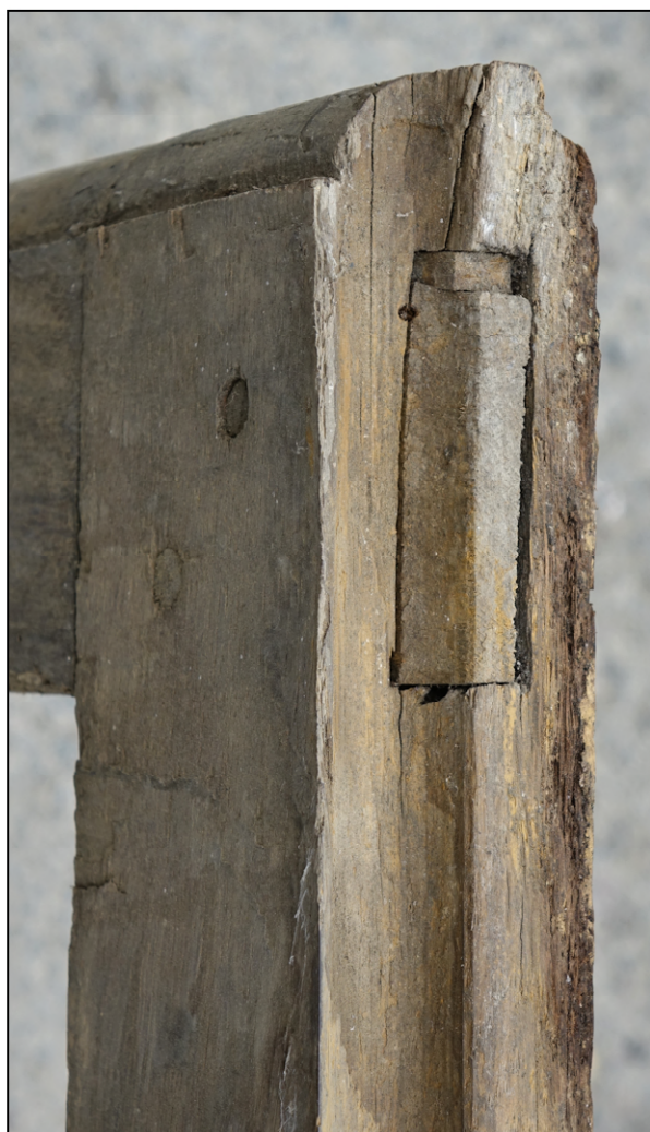
Fig. 4.4. Assemblage du battant du milieu
