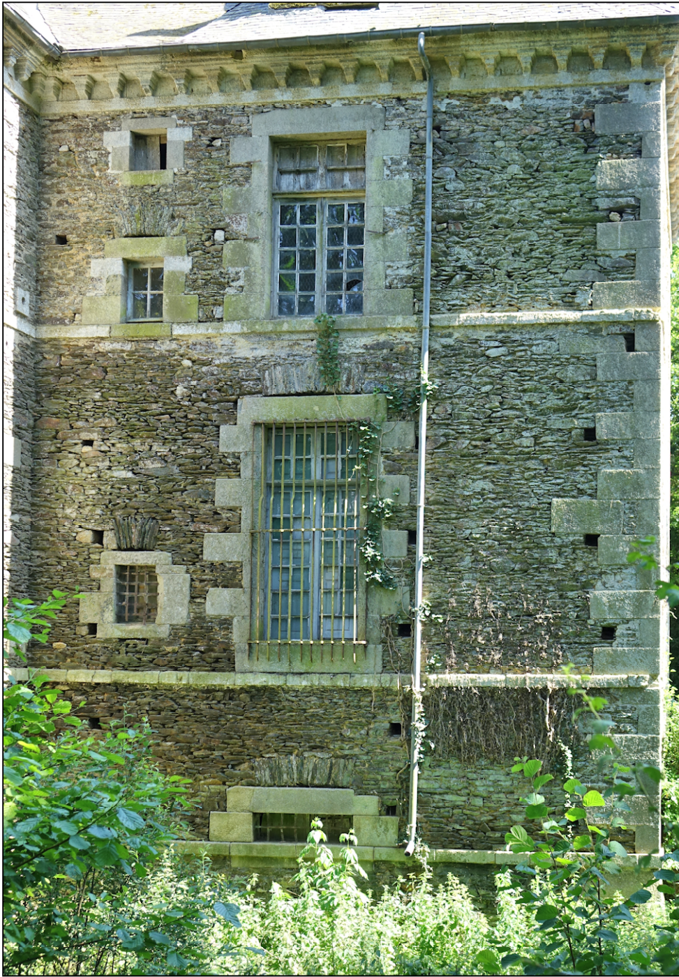
Fig. 2.1. Edifice / façade nord
