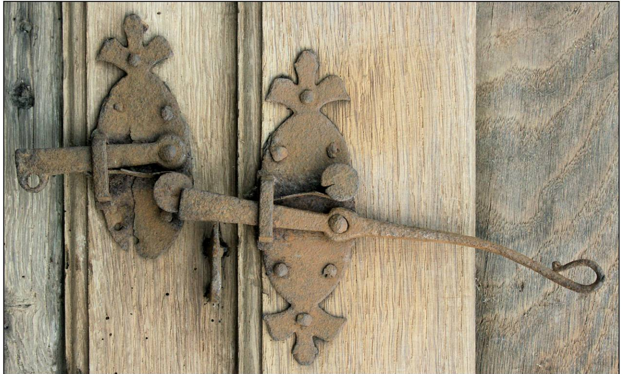
Fig. 1.2. Loquets à ressort
