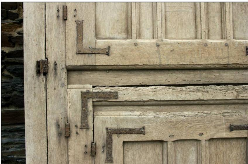
Fig. 3.3. Recouvrement des bâtis
