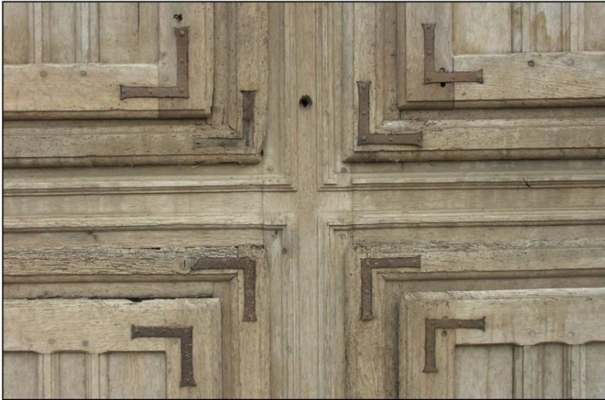
Fig. 3.1. Recouvrement des bâtis
