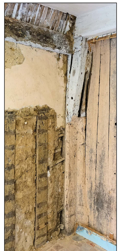
Fig. 2.5. Poteau gauche de la croisée
