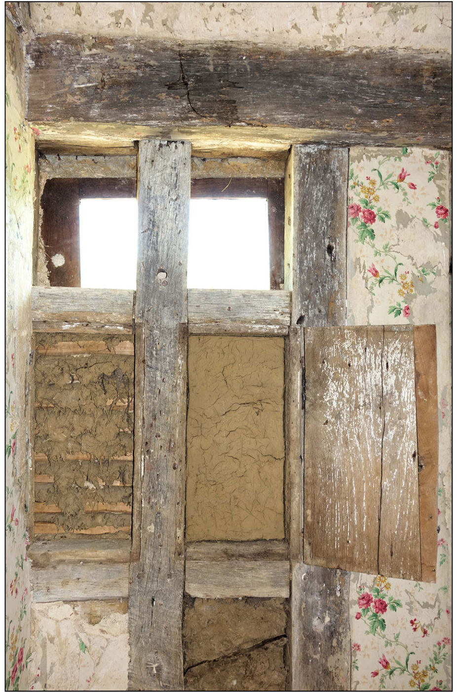
Fig. 2.2. Croisée (après dégagement des compartiments supérieurs)
