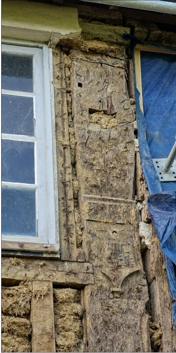
Fig. E.2. La jonction au niveau de l'étage entre le logis neuf (à gauche) et le vieux logis (à droite, sous la bâche) / 2020.
