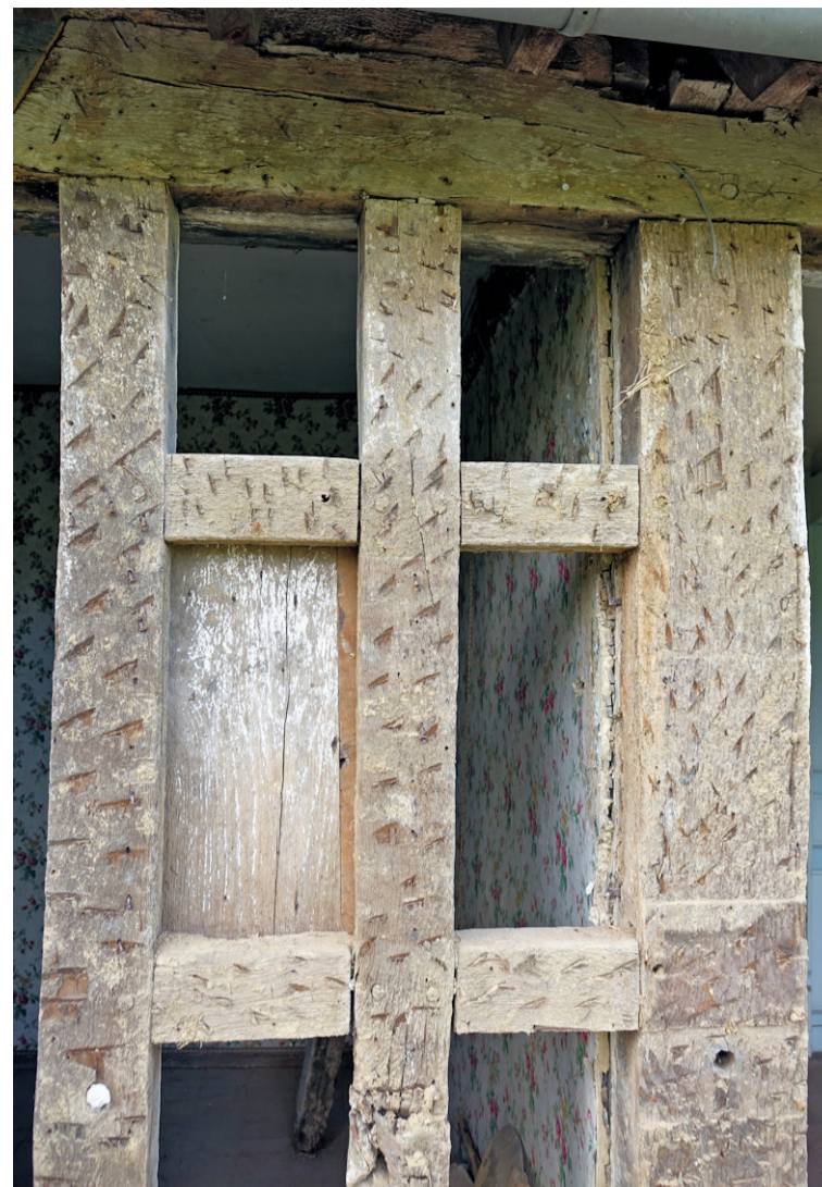
Fig. E.7. La croisée après dépose de la fausse-fenêtre (2020)
