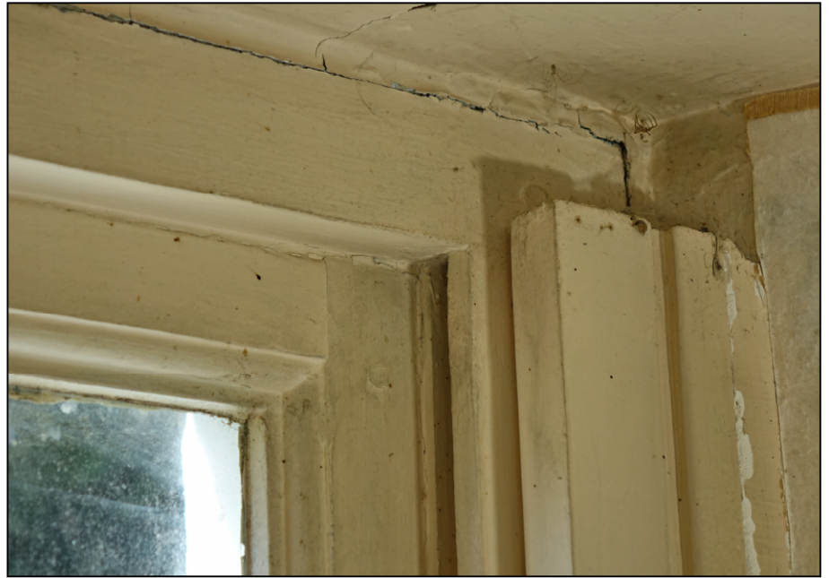
Fig. 3.2. Traverse en chapeau du bâti dormant
