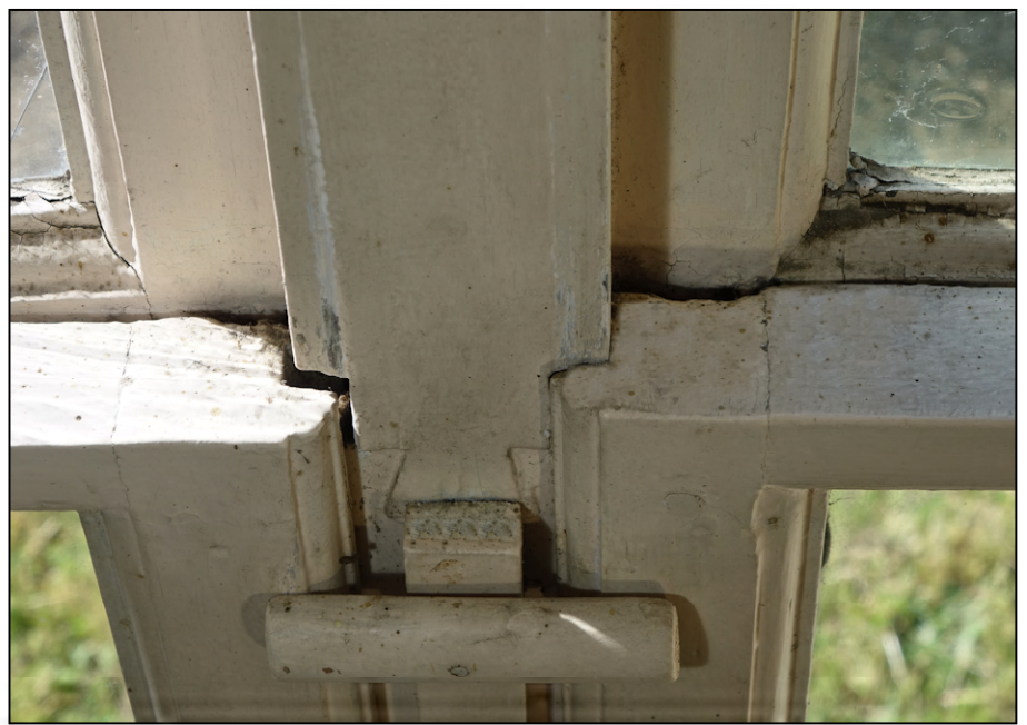
Fig. 3.4. Pied de la pièce à queue
