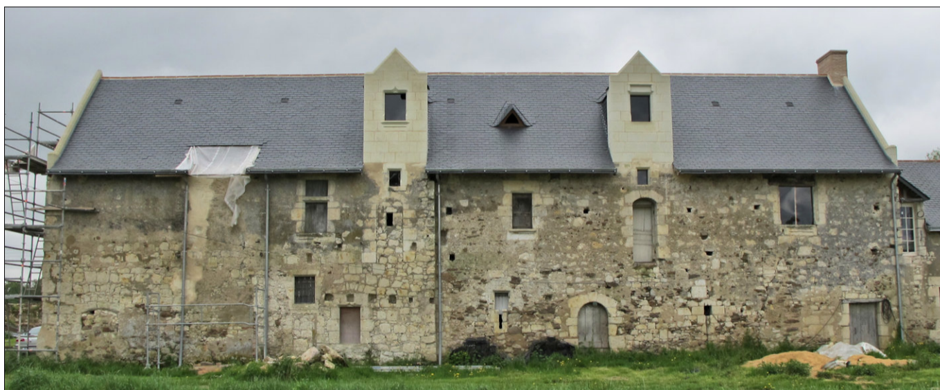
Fig. E.1. La façade nord-est en cours de restauration, en 2013. A l'étage, au centre, le châssis conservé.
