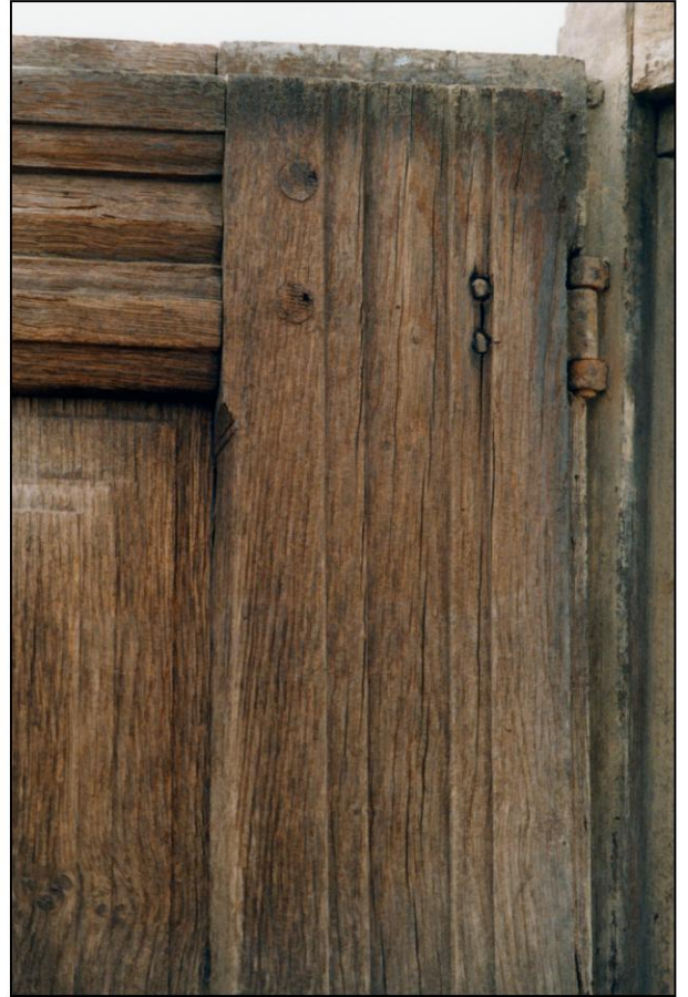
Fig. 2.3. Volet / mouluration et ferrage
