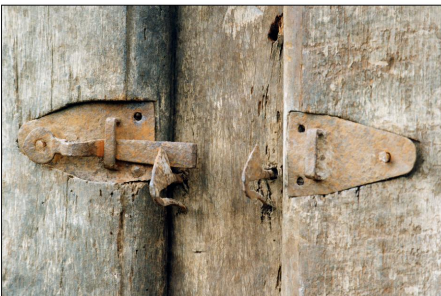
Fig. 2.6. Volets supérieurs / loquets
