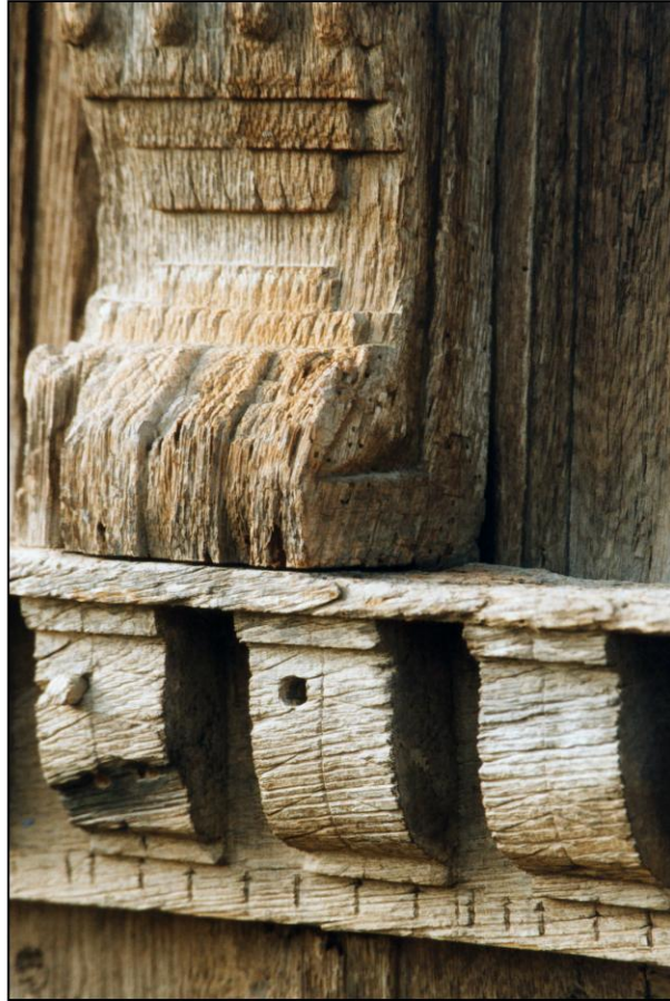
Fig. 2.2. Dormant / traverse à modillons
