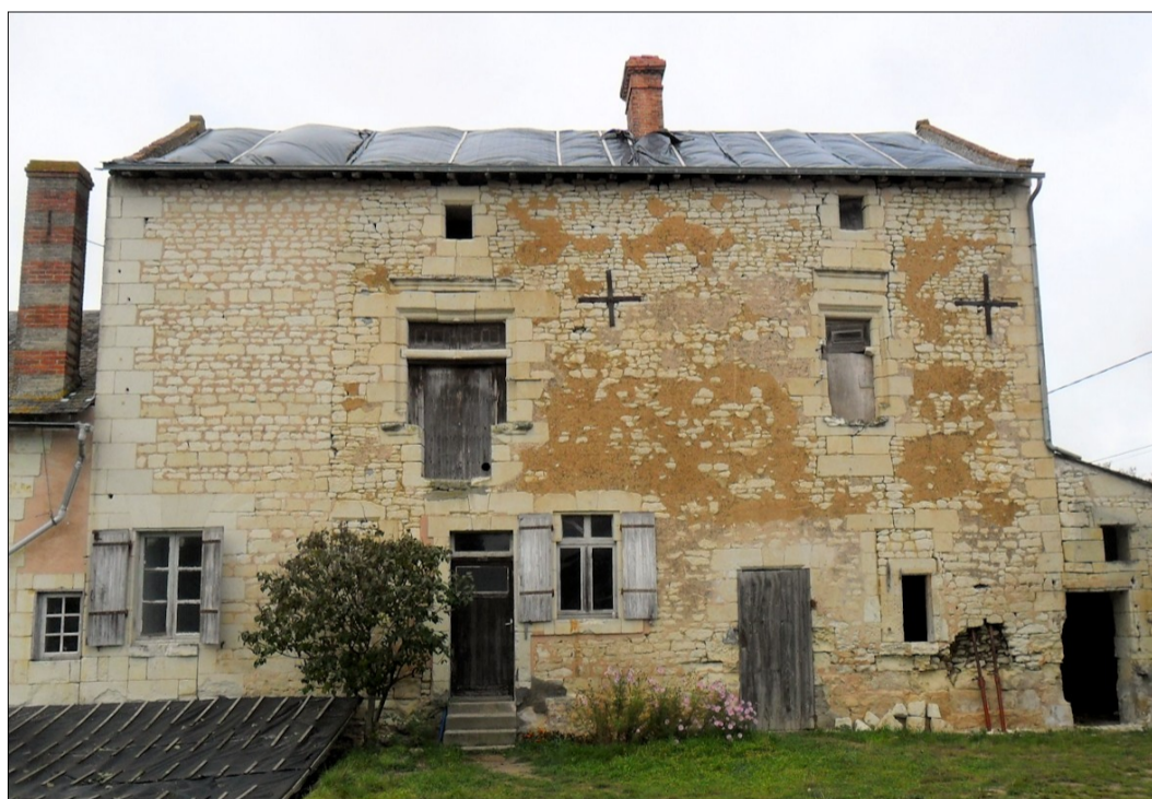
Fig. E.1. Façade orientale avant restauration Photo Pascal Lapôtre
