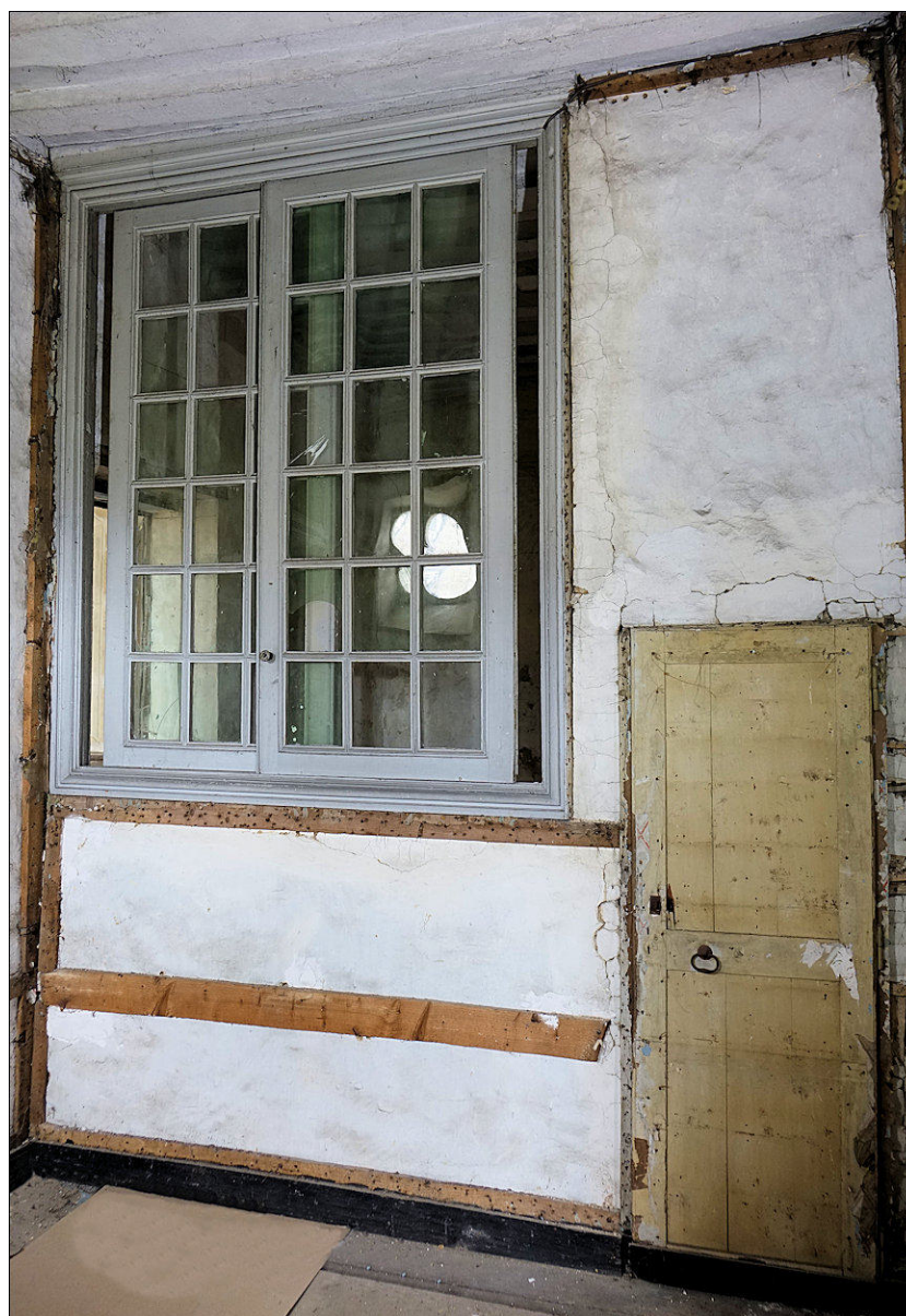
Fig. E.6. Le châssis coulissant vu depuis le palier d'escalier
