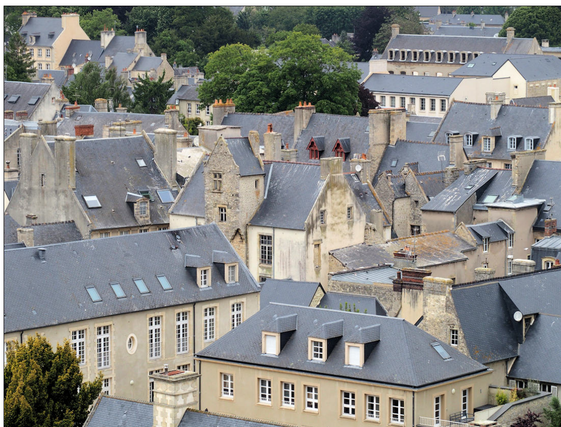
Fig. E.5. La façade sud de l'hôtel de Rubercy, vue depuis la cathédrale
