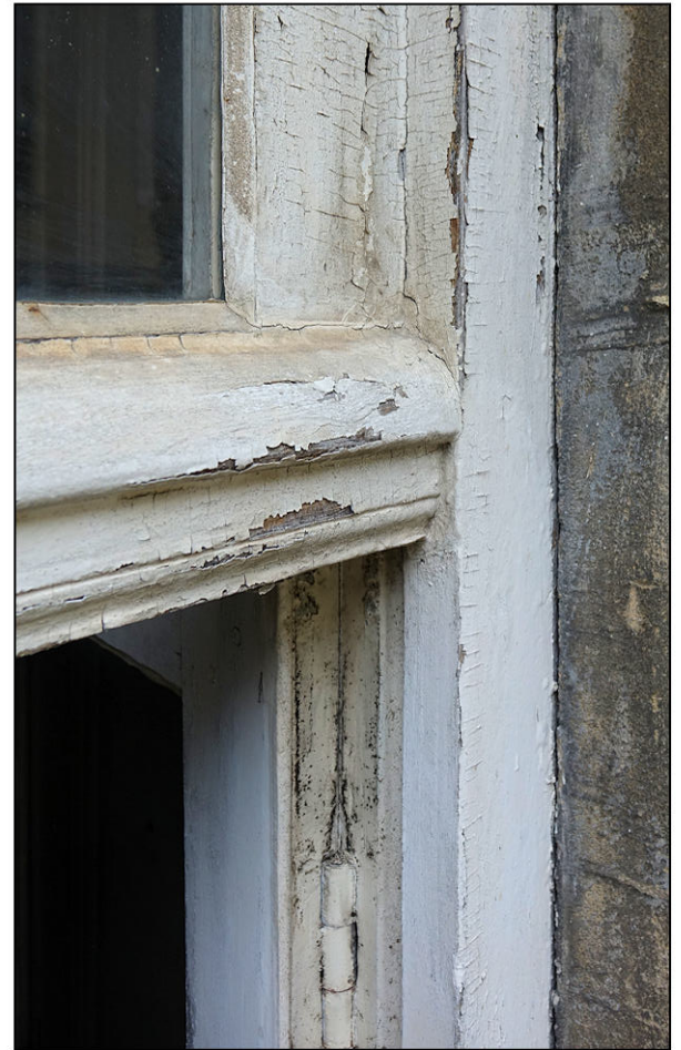
Fig. 2.2. Traverse d'imposte
