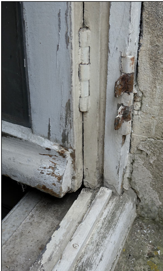
Fig. 2.3. Battant de rive et pièce d'appui
