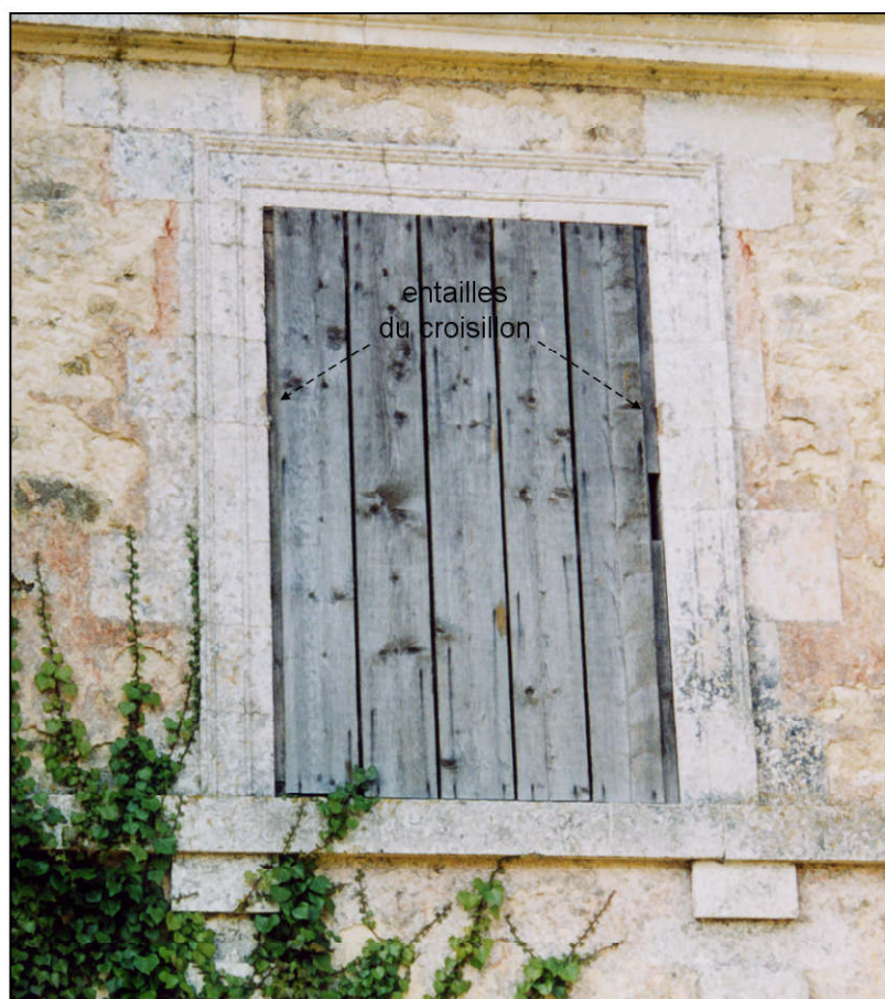
Fig. 1.6. Fenêtre (élévation extérieure)
