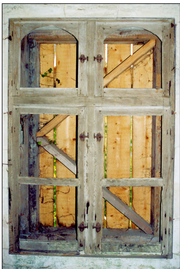
Fig. 1.4. Croisée (élévation intérieure)
