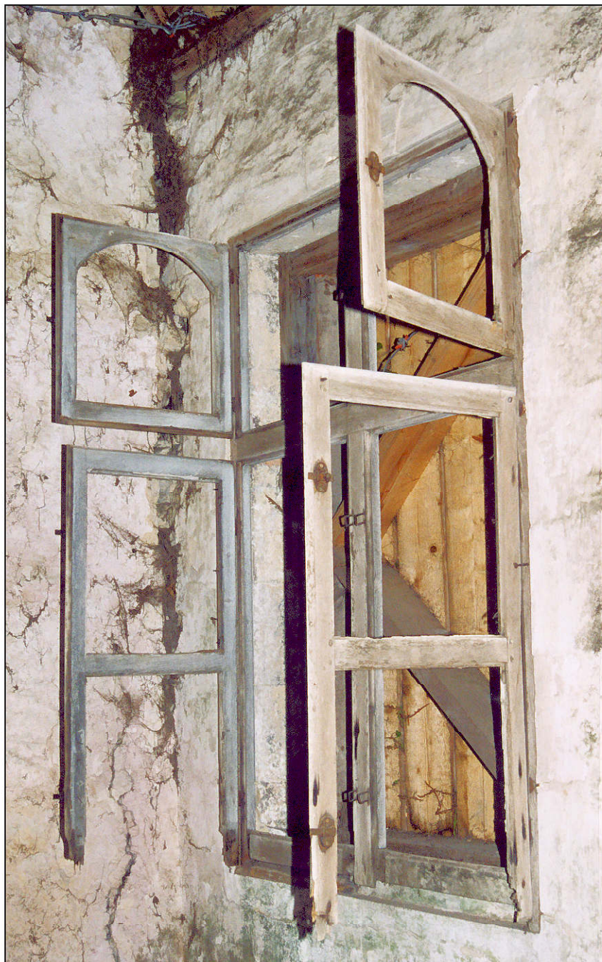
Fig. 1.1. Croisée (élévation intérieure)
