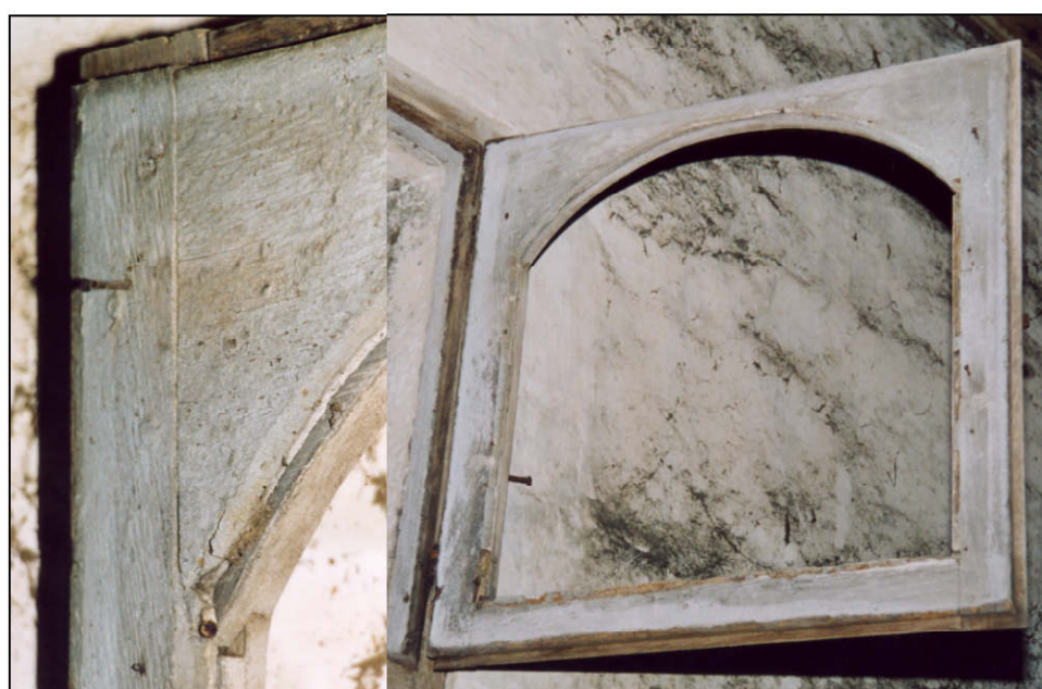
Fig. 1.3. Vantail vitré sup. (assemblage - élévation extérieure)
