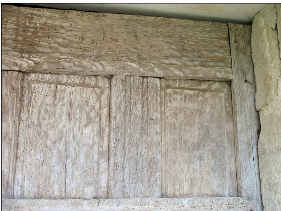
Fig. 6.7. Vantail C / détail (pavillon sud-est)
