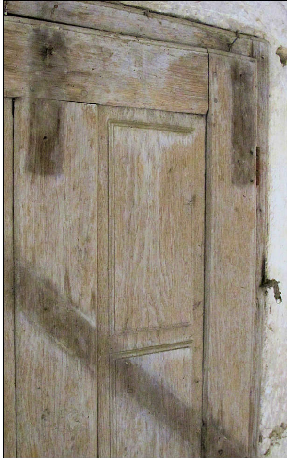
Fig. 6.2. Vantail A / détail (pavillon sud-est)
