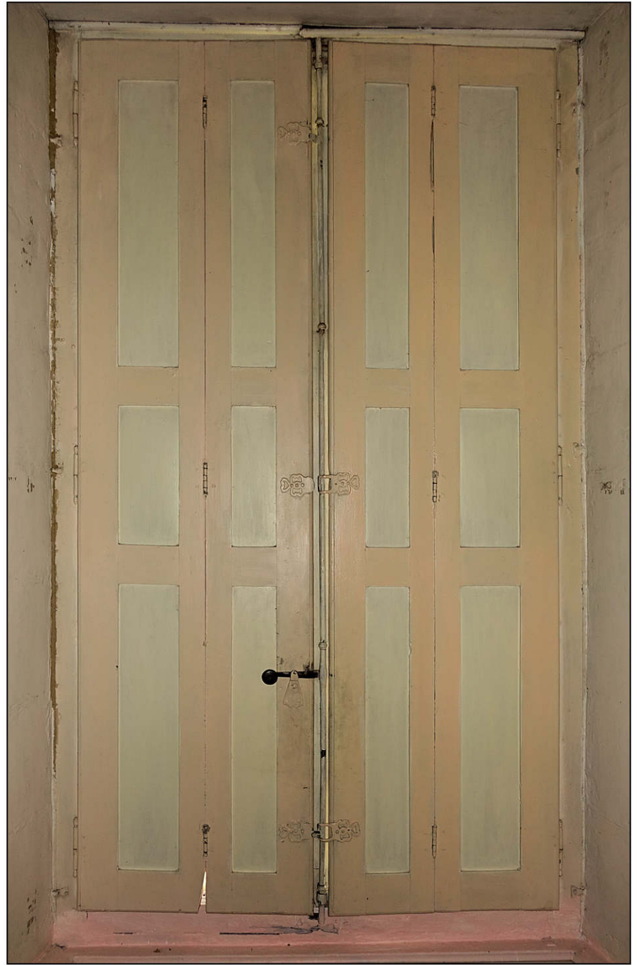
Fig. 8.2. Logis / façade ouest
