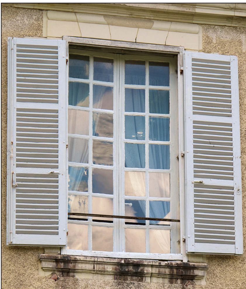
Fig. 8.3. Logis / façade ouest
