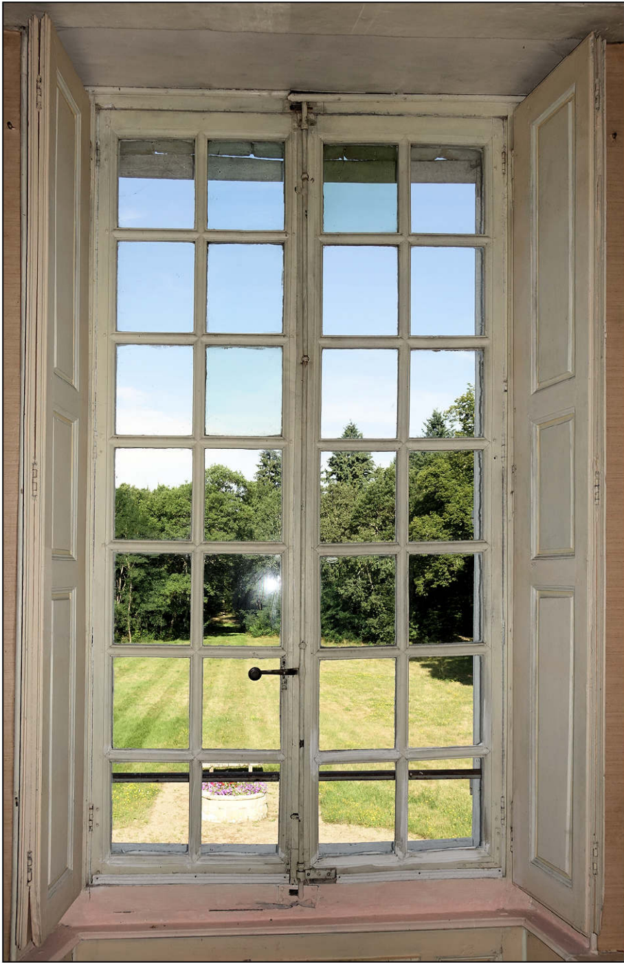
Fig. 8.1. Logis / façade ouest
