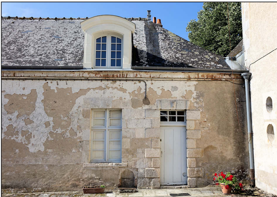
Fig. 2.2. Aile sud / façade nord
