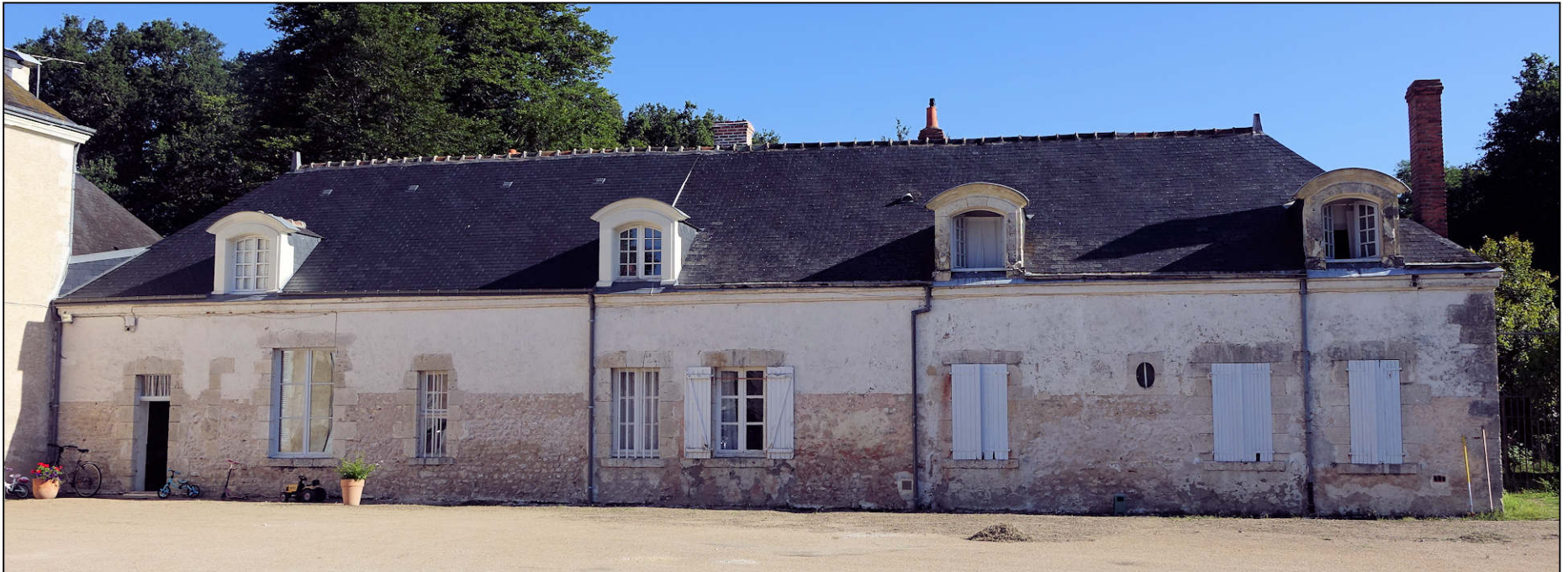
Fig. 2.1. Aile nord / façade sud
