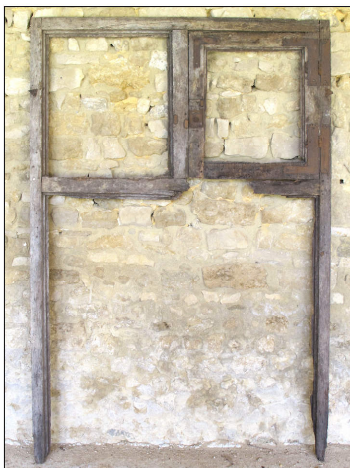
Fig. 1.3. Croisée (élévation intérieure)
