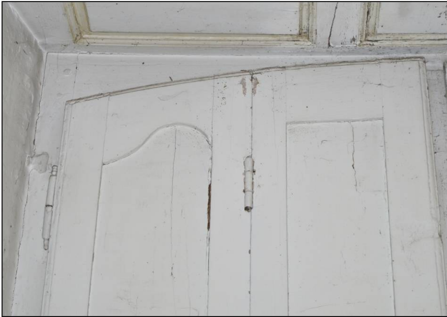
Fig. 3.1. Ferrage du volet brisé (croisée B)
