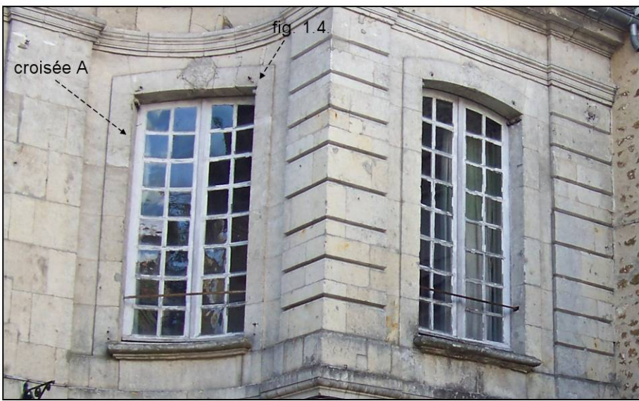
Fig. 1.2. Façade nord (premier étage)
